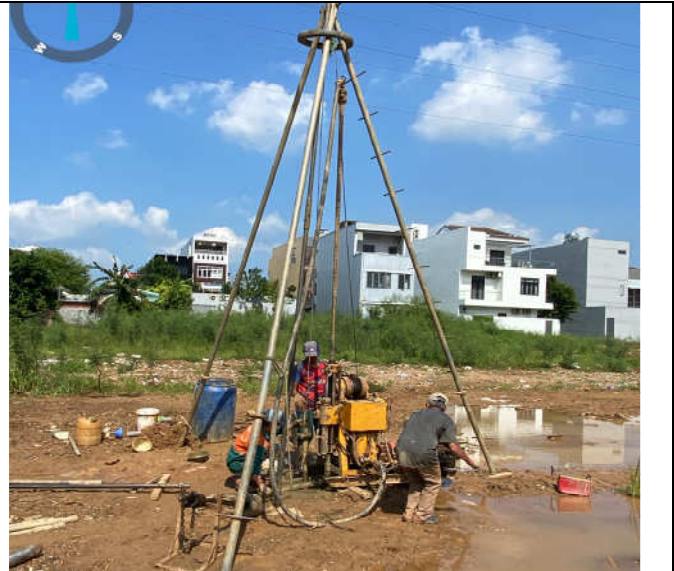
Công tác lắp đặt máy khoan
